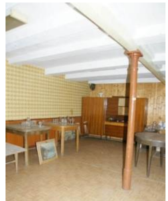
Der Kindergartenraum mit Säule
