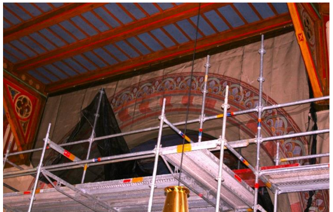
Bild: Aufspannen des Netzes am Chorraum
